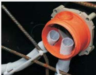
Zamontowane rury giętkie do korpusu KBT.
