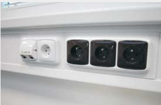
Przykład montażu kanału parapetowego PK 140X70 D.
