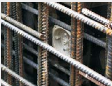
Wieczko KBV zamocowane na zbrojeniu.
