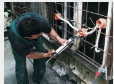
Uszczelnianie przepustów (kit).
