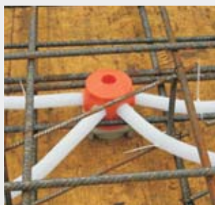
Przykład zastosowania na zbrojeniu poziomym.
