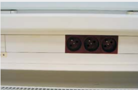
Przykład montażu kanału parapetowego PK 120X55 D.
