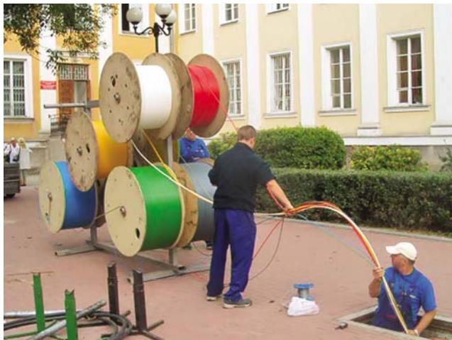
Fot. 2 Specjalna wiązka 8-miu mikrorur Novomicro – 3 x 10, 2 x 7 , 3 x 5 zaciągana do rurociągu światłowodowego w Siedlcach.
