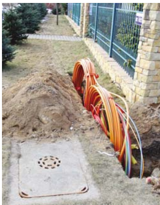
Fot. 11 Wiązki Novosplit 7/8 w trakcie instalacji
