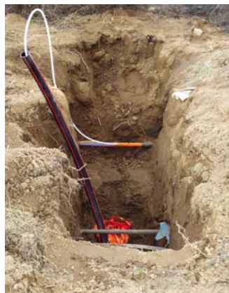
Fot. 12 Rozgałęzienie wiązki Novosplit z przepustem z OPTO 40
