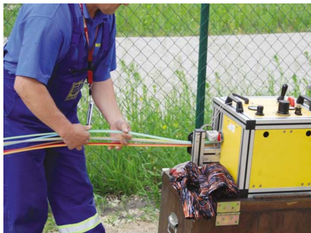
Fot. 5 Wdmuchiarka do mikrorur Przedsiębiorstwa WPRT, wdmuchująca siedem Novomicro 7 do rury Opto 40 w Szczecinie
