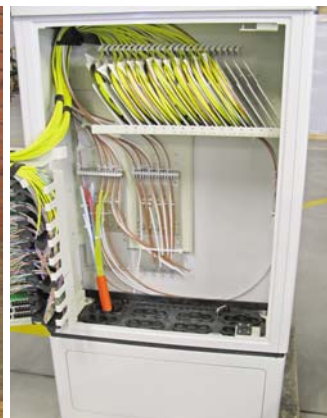
Fot. 14 Szafa dystrybucyjna w trakcie wyposażania w mikrorurki doprowadzone do kaset spawów
