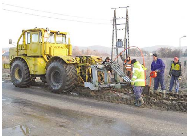
Fot. 7 Instalacja wiązki Novonet DB 5/10 wzdłuż drogi gminnej plugoukładaczem
