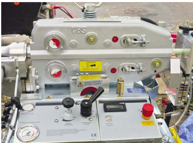
Fot. 4 Wdmuchiarka do mikrorur P. H. „Elmat” sp. z o.o. z Rzeszowa przygotowana do wdmuchiwania trzech Novomicro 10 do rurociągu światłowodowego w Brzesku.
