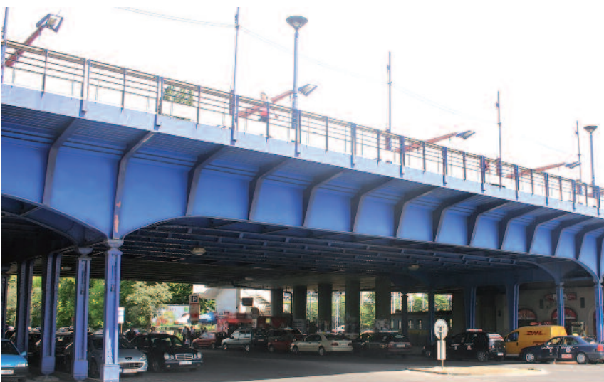
Trzy rurociągi SMR 160 zainstalowane na moście dworcowym w Poznaniu
