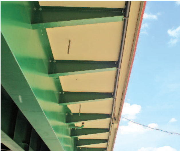
Podwójny rurociąg z rur SMR 160 i 110 zamontowany na moście w Puławach
