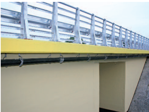
Dwa rurociągi SVA 110 zamontowane na remontowanym wiadukcie w miejscowości Chojna
